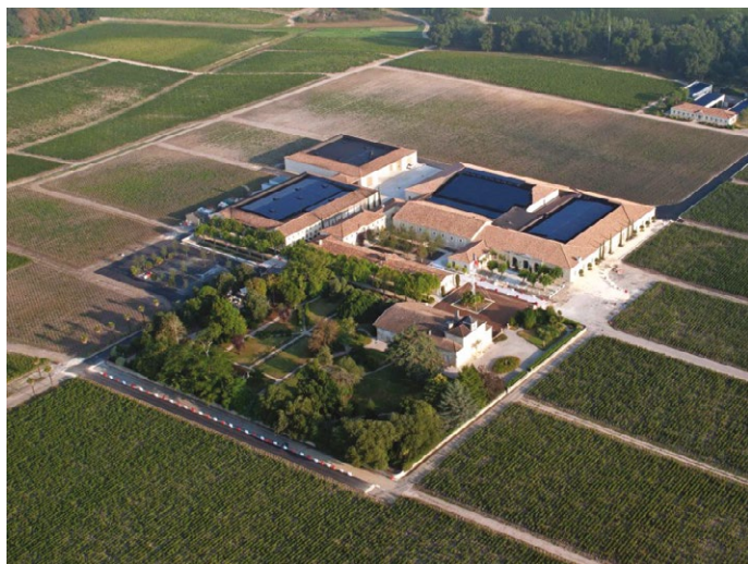
Panneaux photovoltaïques, Château Montrose
